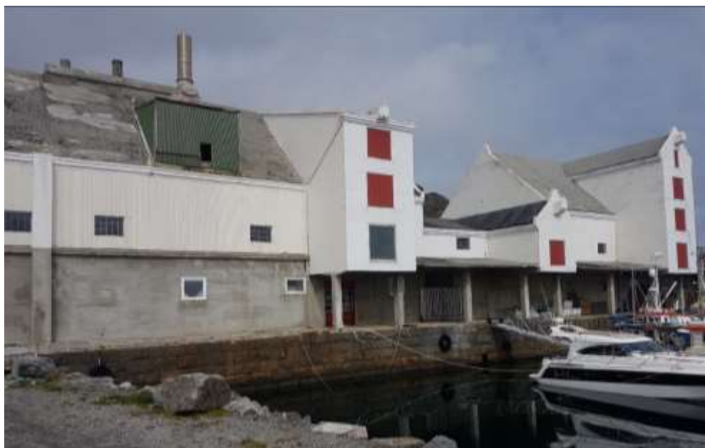
Figur 13 Fronten av brygge øst. Foto: AV
