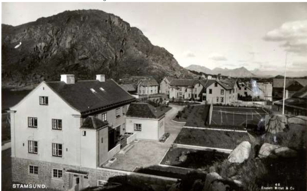
Figur 18 Væreiergården i Stamsund, oppført og Bygget i 1935 Foto: Jan Habberstad, 2016
