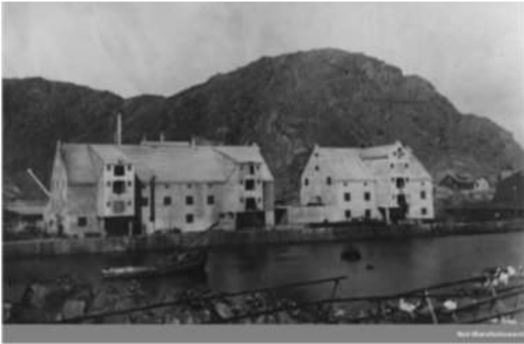
Figur 14 Opprinnelig bebyggelse, Stamsund Sildoljefabrikk, tatt i 1930. Foto og kilde: Nordlandsmuseet.
