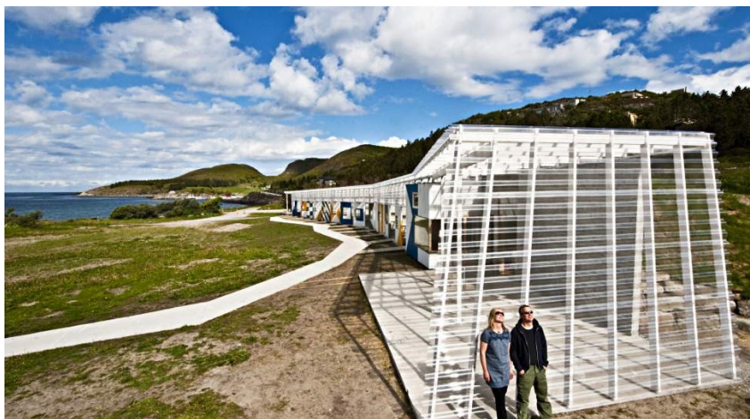
Eksempel: Stokkøya sjøsenter – bebyggelse er bygget inn i terrenget i bakkant
