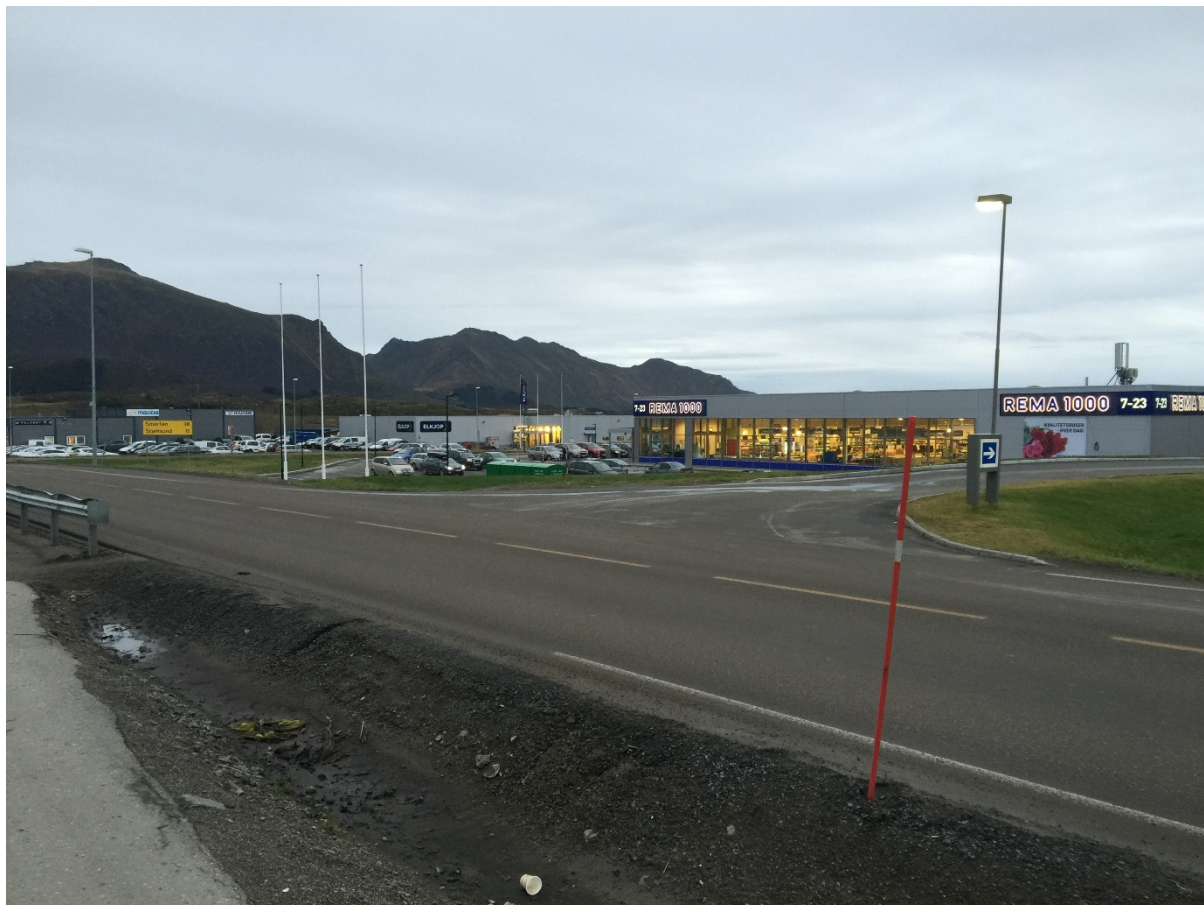
Figur 5. Planområdet sett fra Idrettsgata mot sørøst. Bilde fra befarig i november 2015. Foto: Gøran Antonsen, Norconsult AS.
