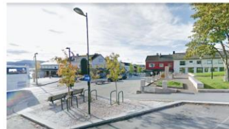
Torget i Fauske som strekker seg fra havet, over hovedveien og videre i form av en park (Bilde: google street view)
