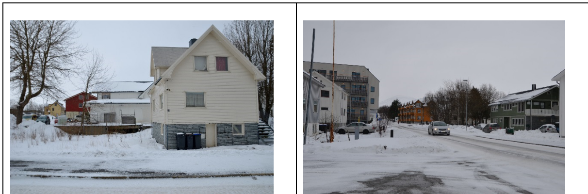
Bildet til venstre viser eksisterende hus som skal rives på 18/50. Bildet til høyre viser tomten bak det grønne huset.
