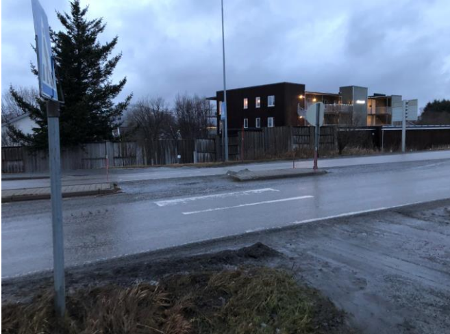
Figur 7: Gangfelt ved rundkjøringen mellom E10 og Sjøveien
