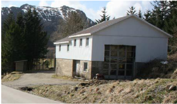
Figur 28. Eldre verksted/lagerbygning som i dag benyttes som lager, Profil 550, gnr. 16, bnr. 1, fnr. 67 foreslås innløst.
