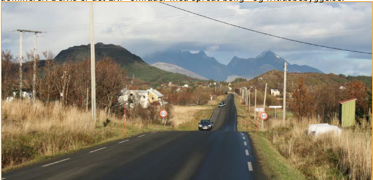
Figur 3. Spredt boligbebyggelse samt landbruksarealer langs fylkesveien.
