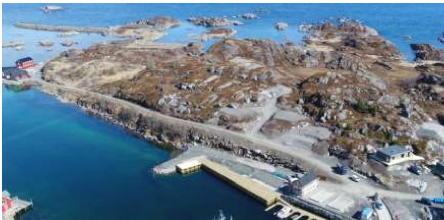
Området for ny bebyggelse sett mot øst. Dronebilde Jonassen maskin og transport as
