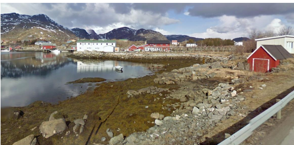
Bilde 26: Dagens situasjon sør for avkjørsel, retning nord (Kilde; Google Maps)
