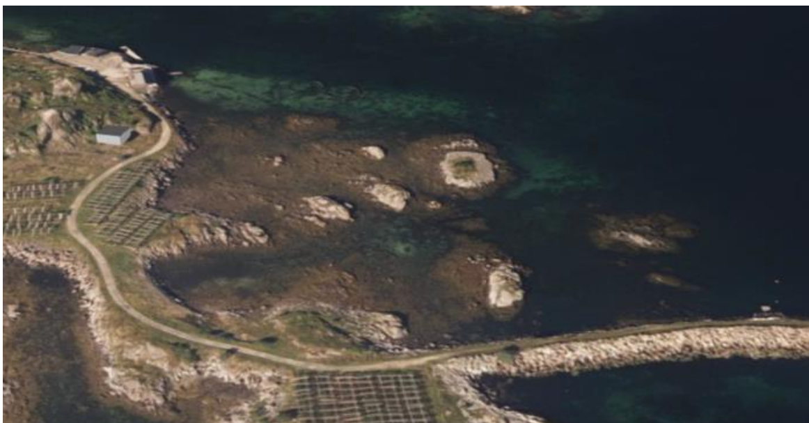
Bilde 23: Dagens situasjon ved tiltaksområdet (Kilde; Multiconsult 3D App.)
