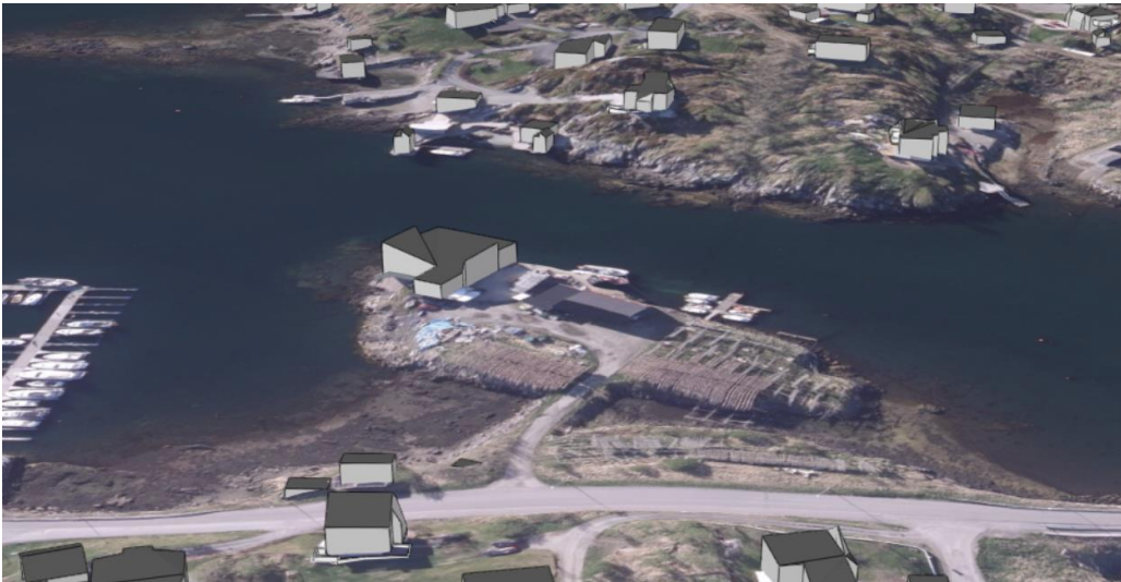
Bilde 24: Dagens situasjon ved tiltaksområdet (Kilde; Multiconsult 3D App.)
