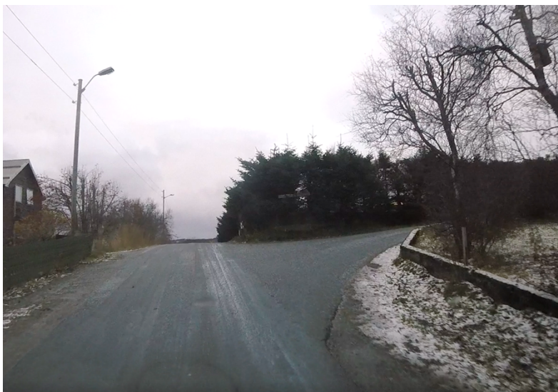
Figur 3-6 Kryss Gymnasveien x Tore Hjorts vei er et av kryssene med dårlig sikt
