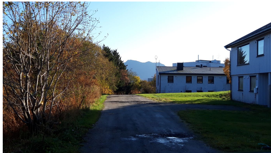
Flere atkomstveier i Gravdal mangler asfalt (Bilde: sha)
