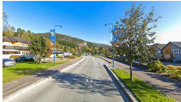
Medjå: ÅDT 2650 (Bilde: google street view)
