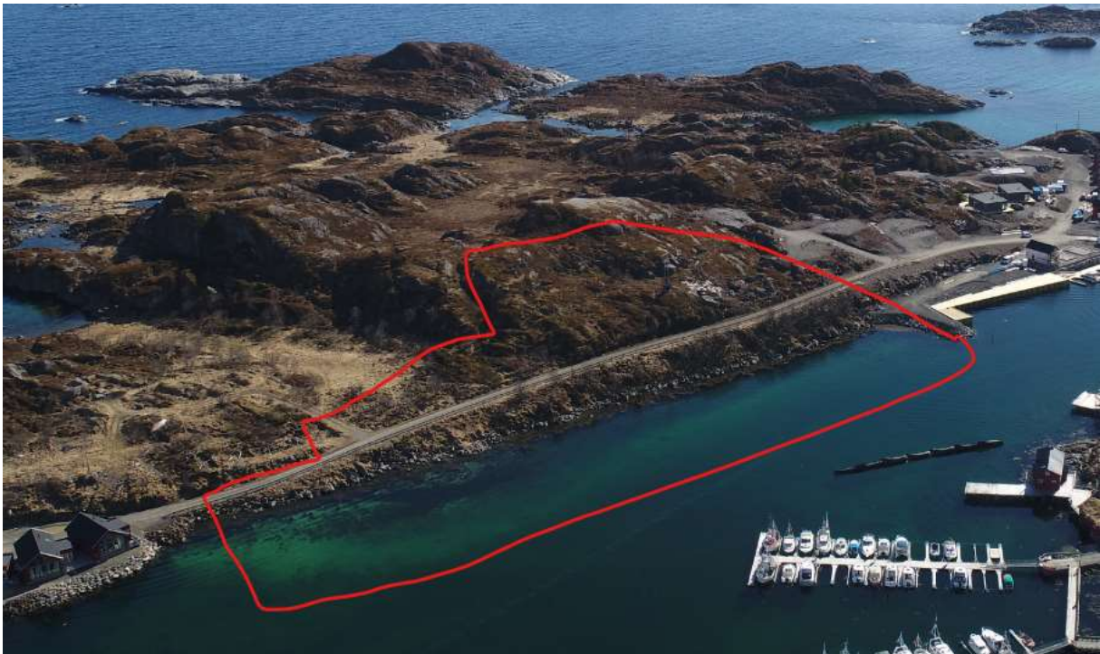
Dronebilde Jonassen maskin og transport as. Reguleringsområdet avmerket
