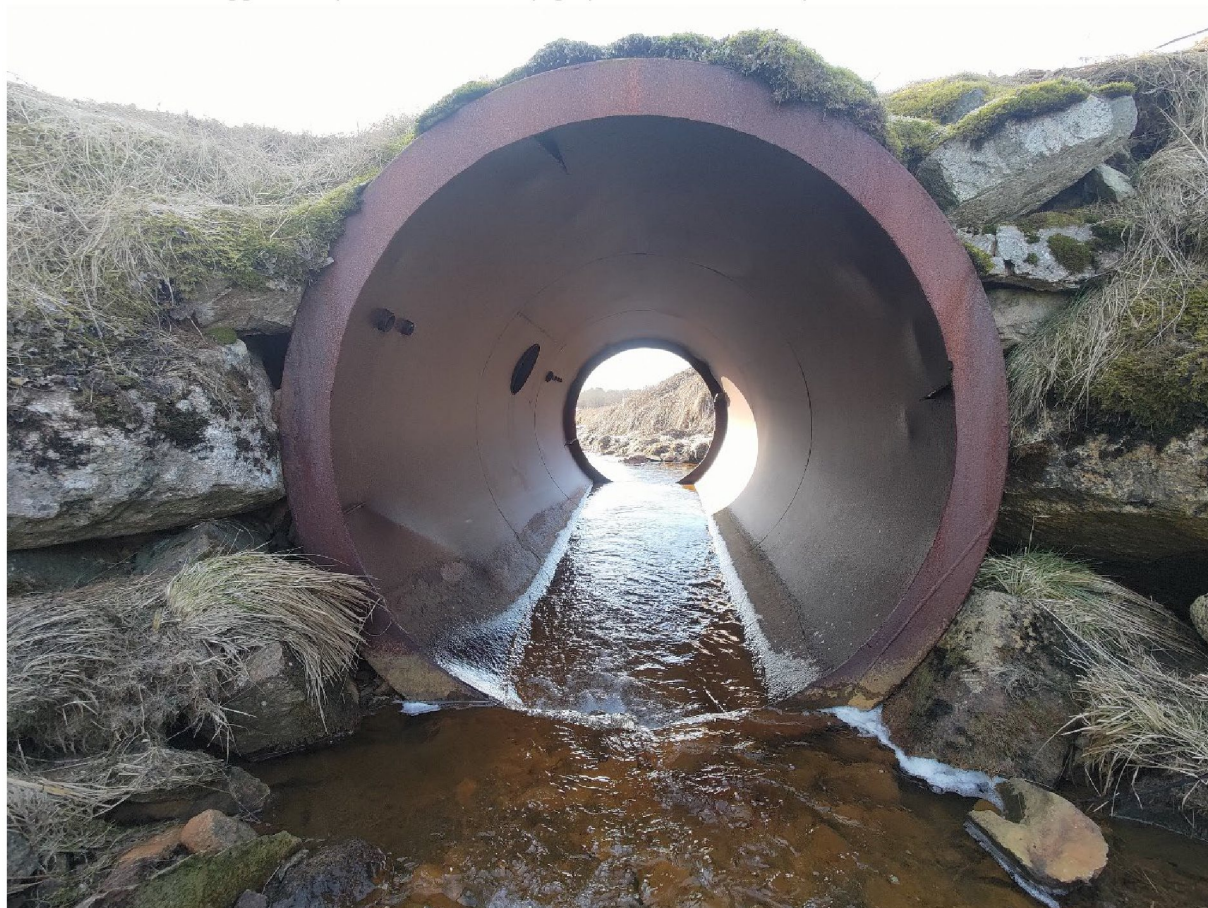
Figur 5: Stikkrenne ved profil 280 – 285
