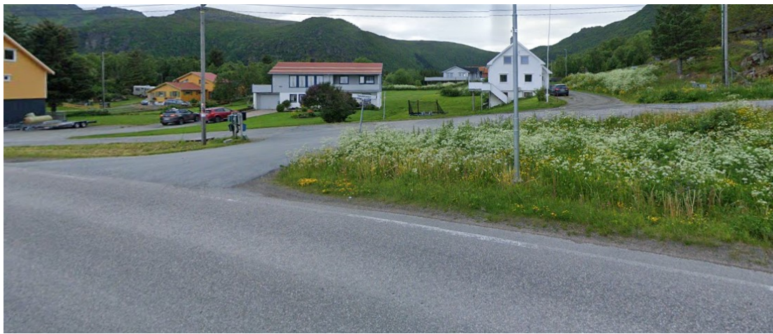
Dagens kryssløsning mellom fylkesvei og Tabakkveien (grusveien som går innover til høyre). Bilde fra Google Streetview.
