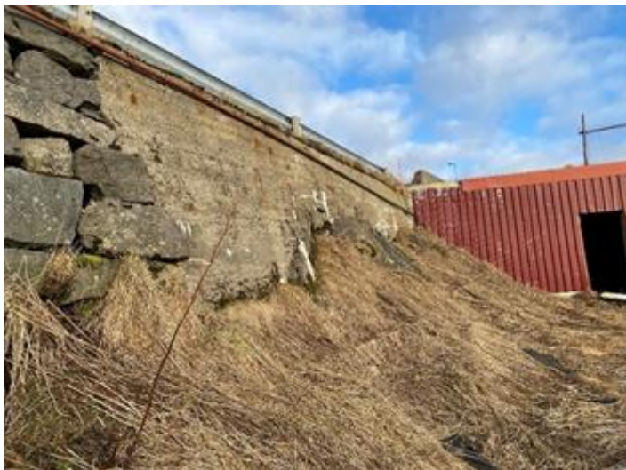
Bilde 10 Eksisterende støttemur langs Fv. 817
