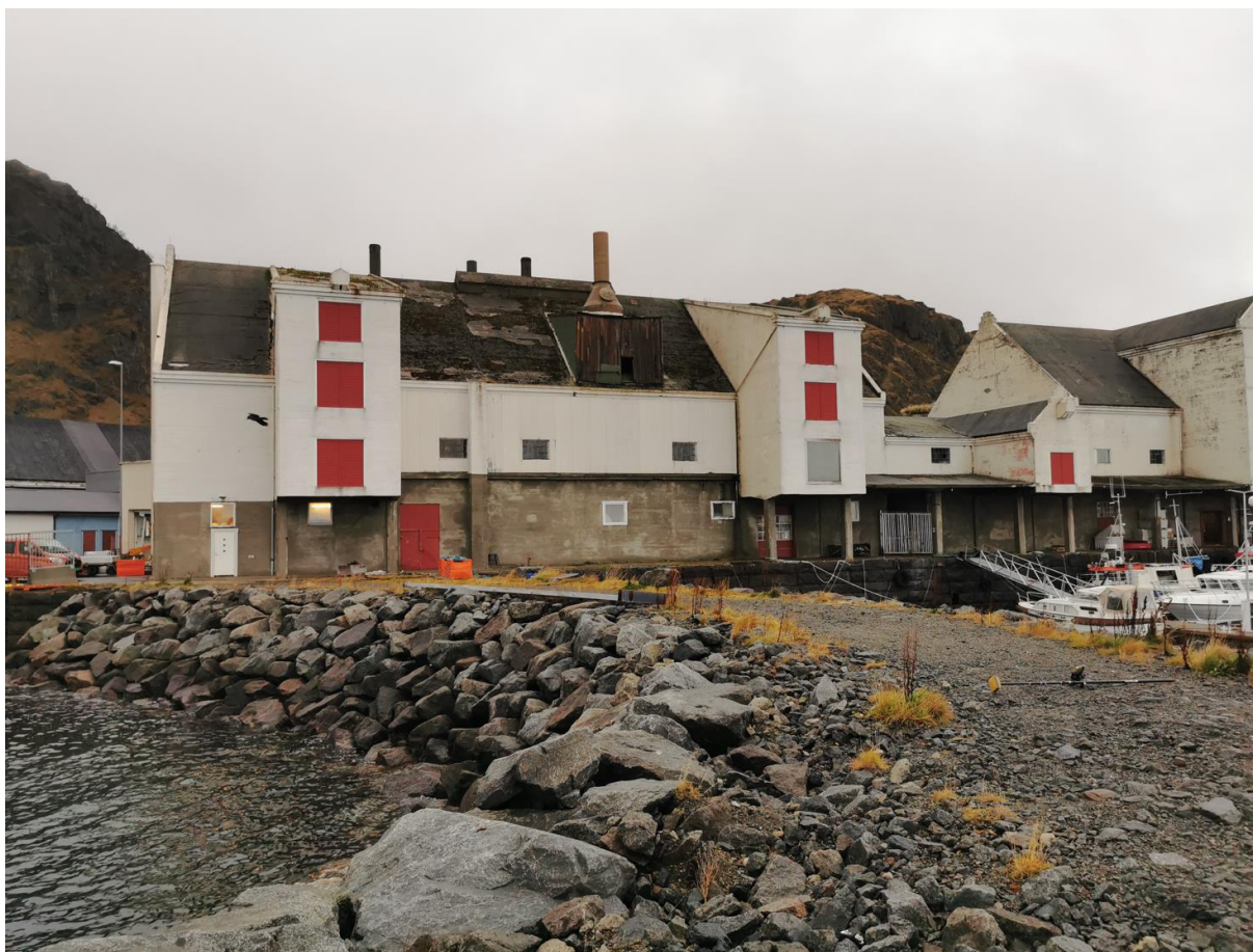
Figur 4: Bygningsmassen slik den fremstår i dag.
