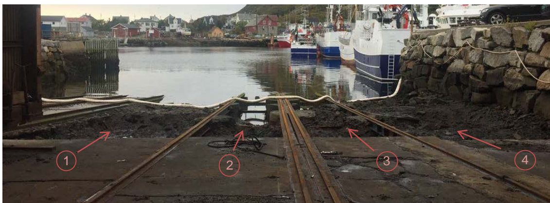
Foto 1: Oversikt over tiltaksområdet, nummer angir plassering og navnet av prøvepunkt. Alle punktene ble utgravd ned til 0,5 m og massene ble kjørt direkte på deponi. Oljelense ble brukt under hele gjennomføringen.
