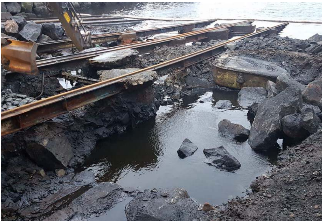
Foto 8: Utgraving av gjenværende løsmasser ned til fjell (utført 7.11.2017.)
