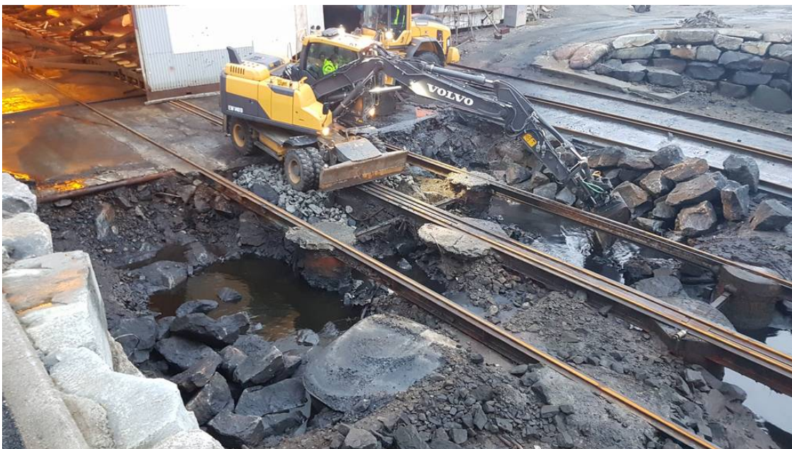
Foto 7: Utgraving av gjenværende løsmasser ned til fjell (utført 7.11.2017.)
