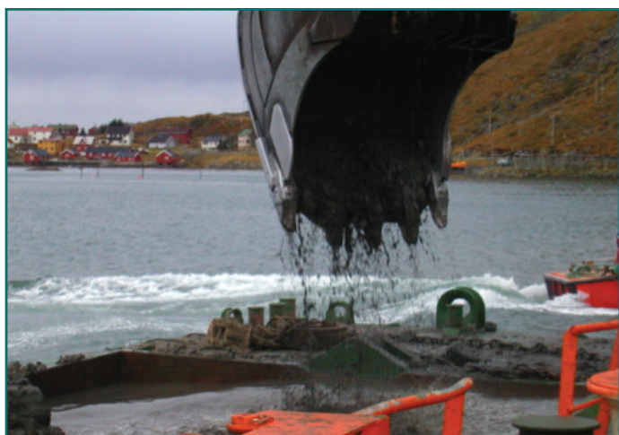
Figur 3: Detalj fra arbeidet med deponering av forurensede masser i Ballstad havn. Foto: Kystverket
