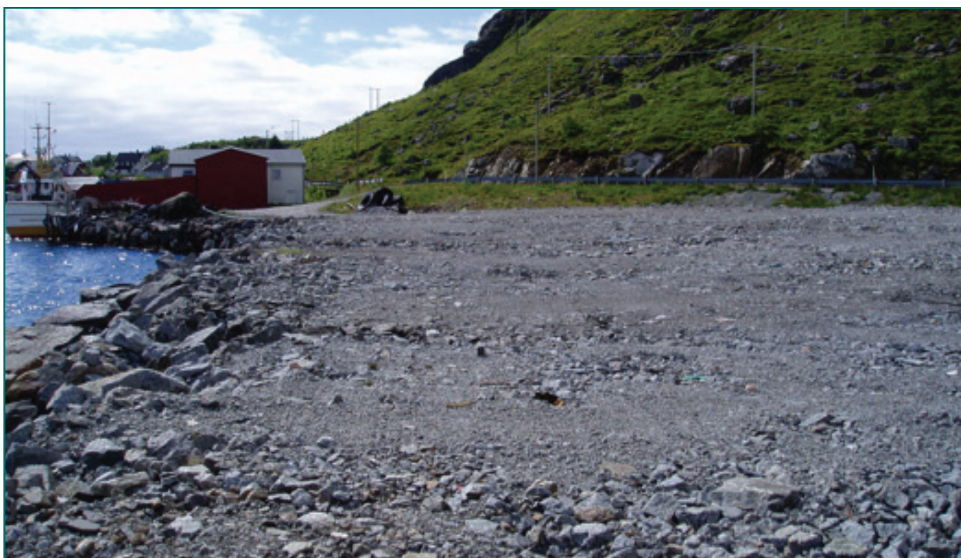
Figur 5: Deponi vest, ferdig tildekket med rene masser og oppmurt kai som barriere mot sjø. Foto: Kystverket
