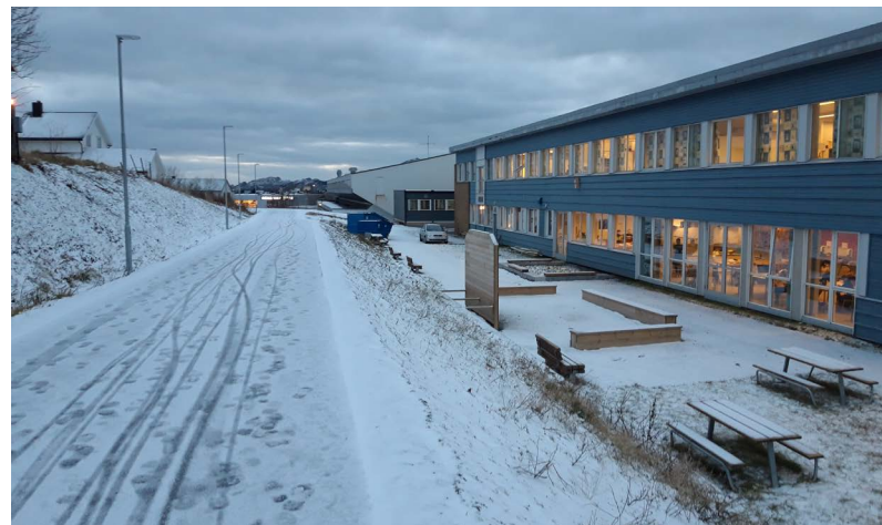
Kobling Lekneshallen-parkeringsplass for VGS nord for Leknes skole med stort potensiale til å videreføres nordover
