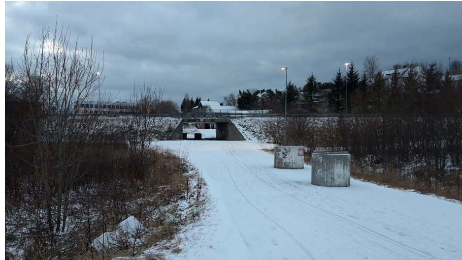
En svært viktig kobling for sentrum nord under E10.
