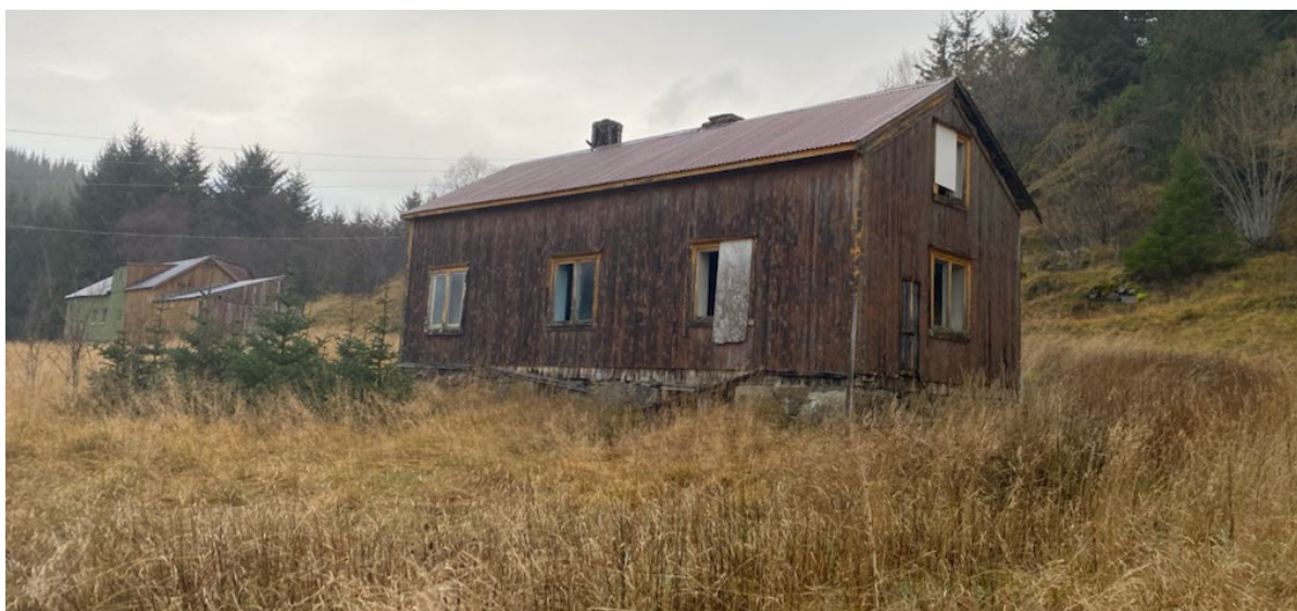
Figur 8: SEFRAK registrert våningshus i BH2 (låve i bakgrunn) .
