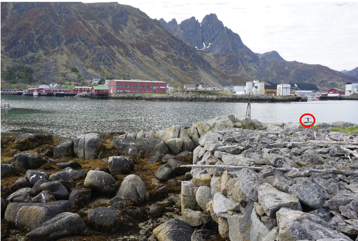
Figur 7. Utsikt mot Magerodden fra holmen med bryggefundament med fortøynings T-bolt i bakgrunn (mot vest).
