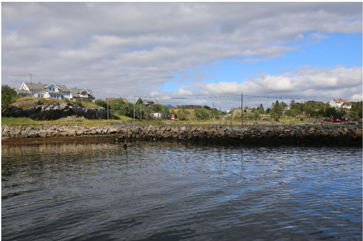
Bilde 5: Eksisterende fylling ut til Reineholmen.
