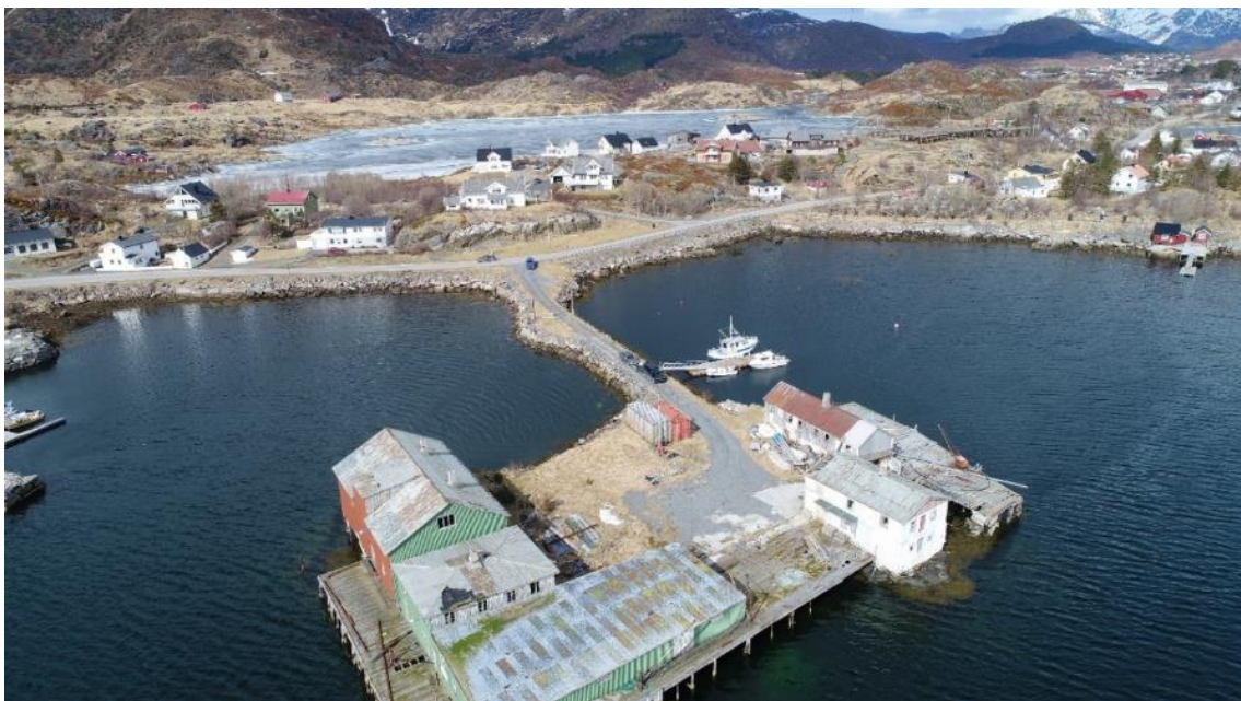
Bilde 3: Reineholmen i april 2018, før bygningene ble revet
