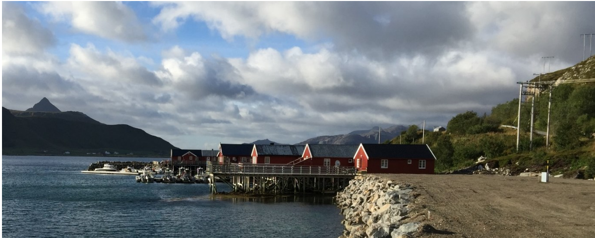
Foto fra befarig 12.9.2016.
